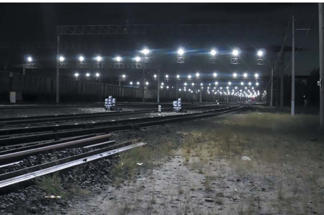
Рис. 1. Ригельные светильники на ж/д станции
